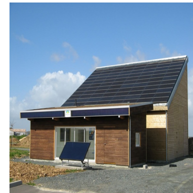
implantation sur une toiture mono-pente
